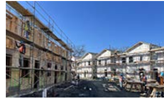
住宅建設作業の様子
