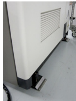
生産設備の床固定
